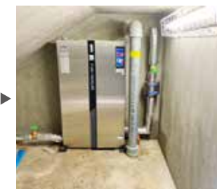
ブースターポンプの新設
