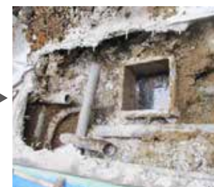
不具合箇所の解体工事
