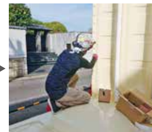
新しい受水槽の組み立て
