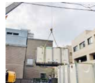
古い受水槽を撤去
