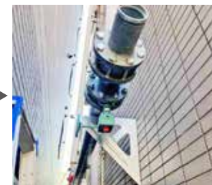
新設管の施工中
