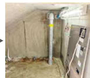
ブースターポンプの撤去
