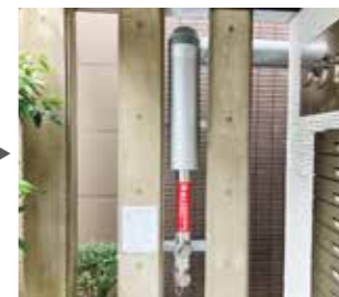
連結送水管完成
