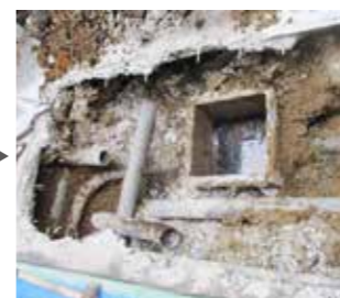
不具合箇所の解体工事
