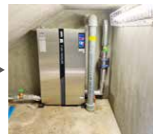
ブースターポンプの新設
