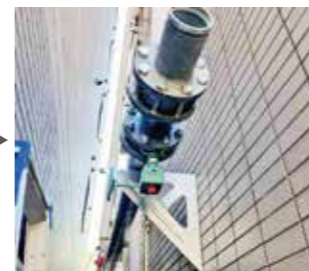
新設管の施工中
