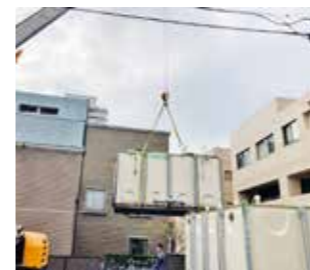
古い受水槽を撤去
