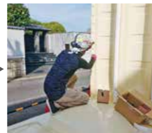
新しい受水槽の組み立て
