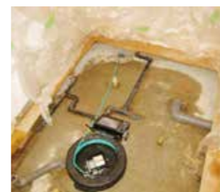
排水管カメラ調査
