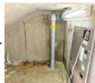
ブースターポンプの撤去
