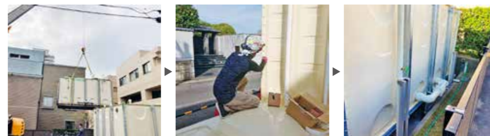
古い受水槽を撤去
